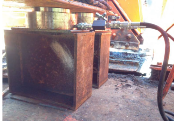
Suministro de apoyos encapsulados y equipo de gateo.
