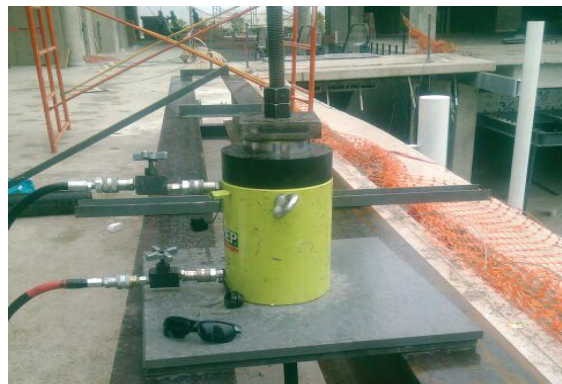
Levantamiento de losa flechada mediante puente metálico y gateo hidráulico.
