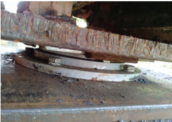
Suministro de apoyos encapsulados y equipo de gateo.
