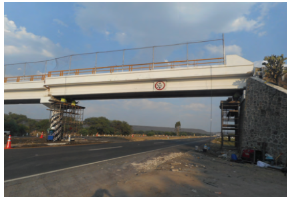
Elevación de rasante / Servicio de gateo en P.I.V.
