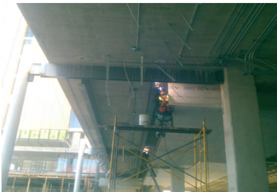
Levantamiento de losa flechada mediante puente metálico y gateo hidráulico.
