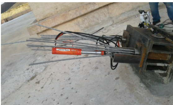
Colocación y tensado de presfuerzo externo en armadura principal.
