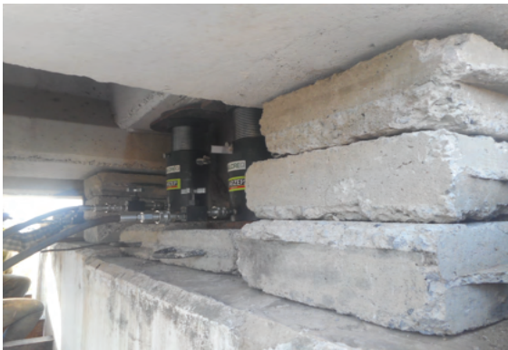
Elevación de rasante / Servicio de gateo en P.I.V.
