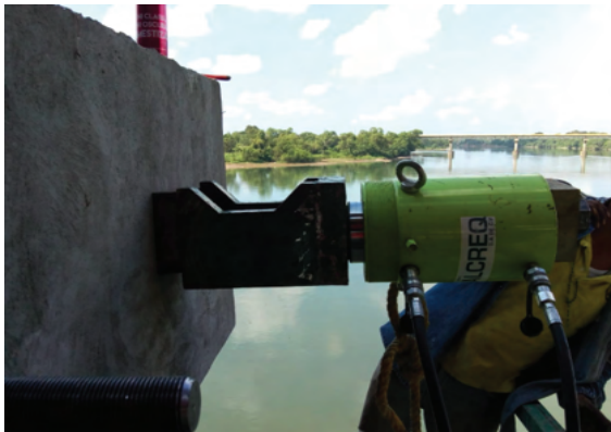
Trabajo de perforación y servicio de postensado de barras de presfuerzo en cabezales de pilas.
